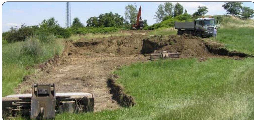
Erdaushubarbeiten für den neuen Sportplatz.
